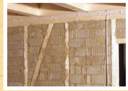
Fachwerkwand mit Lehmausmauerung
