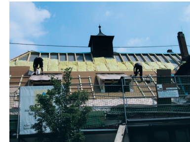
Aufbringung der Dachdämmung
