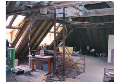
Saal in der Umbauphase
