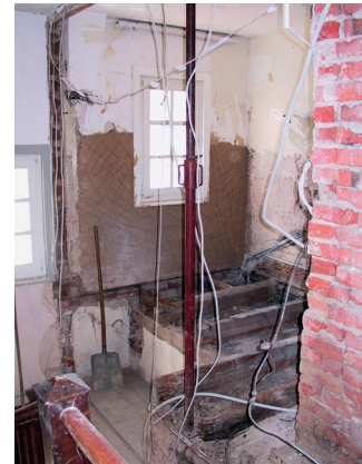
Abbruch innen, ehemaliges Bad
